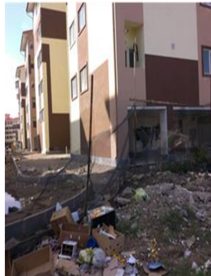
شماره ۷- وجود زباله و آشغال در مسکن مهر رشت. آبان ۹۳
